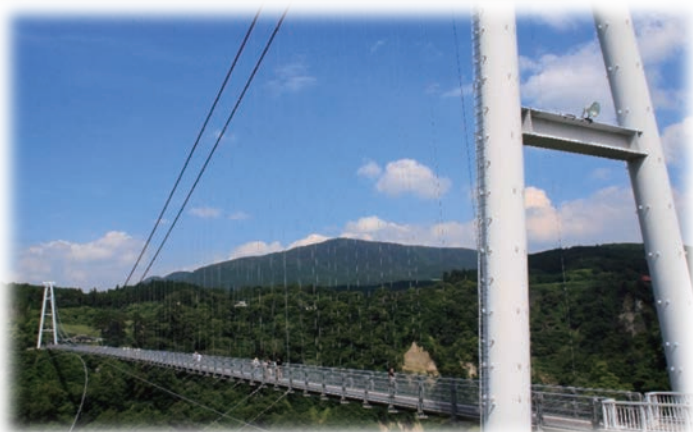
九重“夢”大吊橋（九重町）
